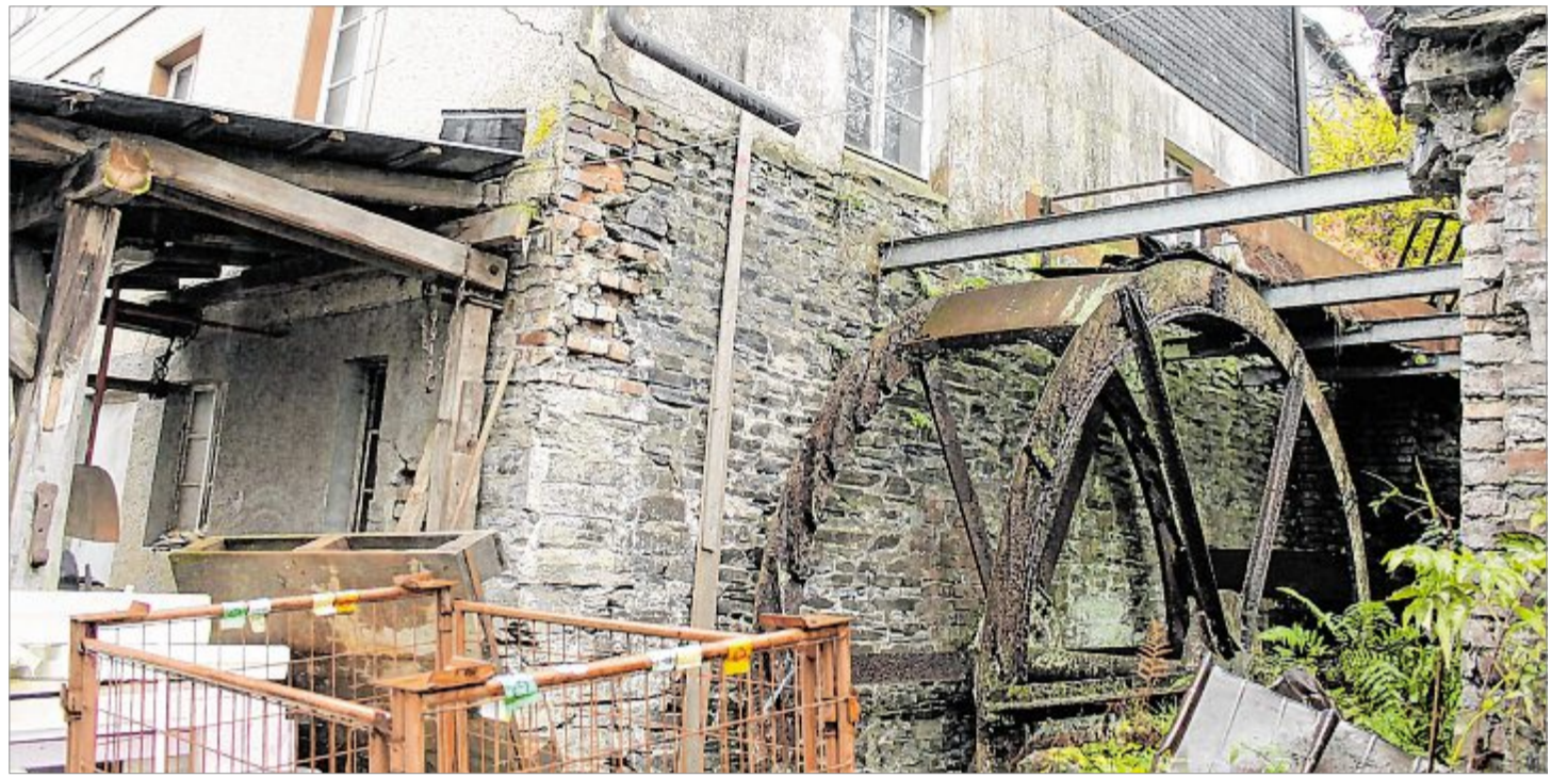
Das Wasserrad an der alten Mühle „Treude“ in Feudingen ist längst nicht mehr funktionsfähig. Ein neues und vor allem stilechtes Rad soll den Betrieb künftig wieder ermöglichen. Fotos: Timo Karl
